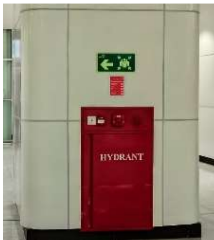
Gambar 12. Sistem Pemadam Api Manual
