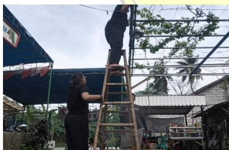
Gambar 9. Pemasangan Bagian Depan Area
