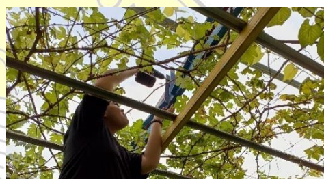
Gambar 11. Pemasangan Bagian Tengah Area
