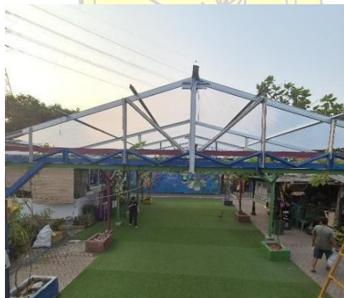
Gambar 13. Hasil Akhir Pemasangan Rangka Atap Kanopi
