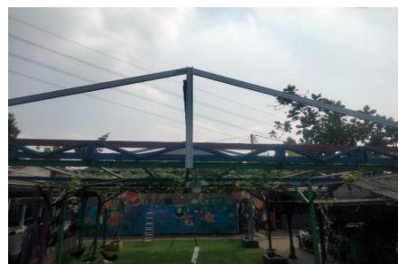
Gambar 10. Hasil Pemasangan Bagian Depan Area
