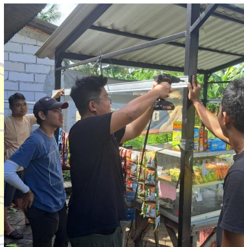
Gambar 11. Pengerjaan Pemasangan Baja Dokumentasi Pribadi. 2024
