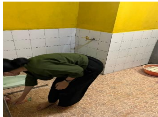
Gambar 3 Kondisi kamar mandi sebelum diperbaharui
