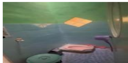
Gambar 4 Kondisi kamar mandi setelah diperbaharui
