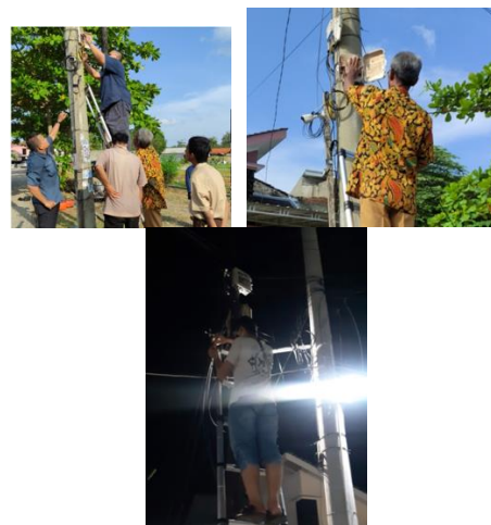
Gambar 5. Proses penempatan ODC dan ODP
