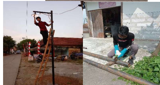
Gambar 2. Pemilihan, Penggalian, Pemasangan PJU
