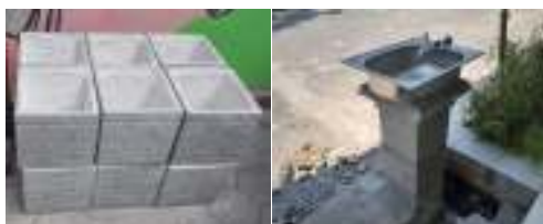
Gambar 3. Bahan yang digunakan untuk konstruksi fasilitas CTPS
